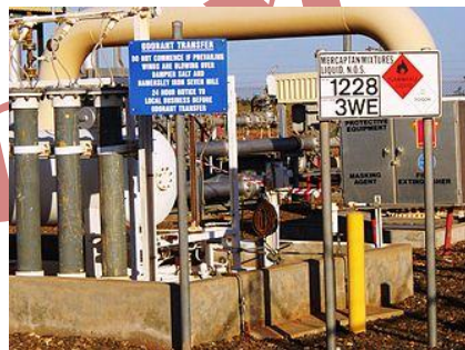
Станция по газопровод за битови нужди за прибавяне на зловонни съединения (меркаптани).
